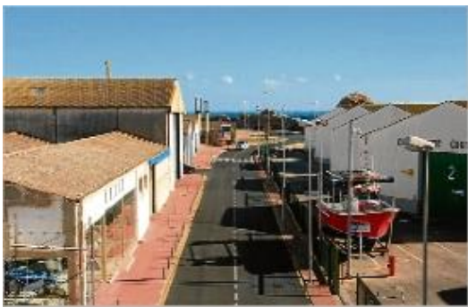
Les obres es faran entre el carrer Roqueta i la carretera de la Fosca.
