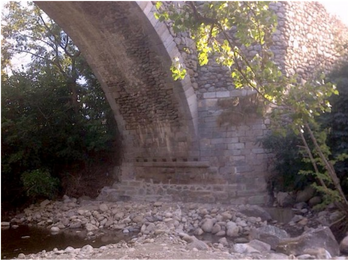
Actuació finalitzada a la base del pont de Sant Martí d'Aravó Foto: Ajuntament de Guils de Cerdanya
