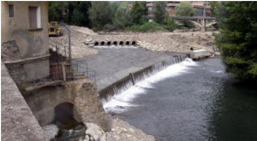
Desmantellen una central hidroelèctrica en desús a Ripoll per millorar la connectivitat del riu Ter
