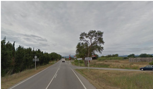
La nova rotonda es construirà a la carretera que porta a l'Escala Foto: EPA.
