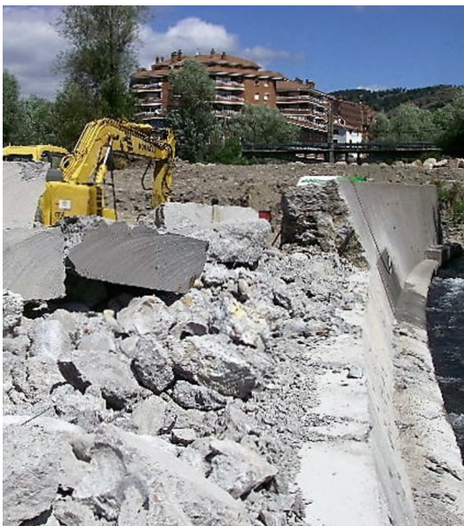
Un detall de les obres que s'estan duent a terme a la resclosa de la minicentral del Ter a Ripoll Foto: EPA.
