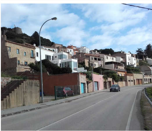
El carril de baixada cap a Sa Tuna, al vial de circumval·lació de Begur, quedarà tallat mentre durin les obres Foto: EL PUNT AVUI.
