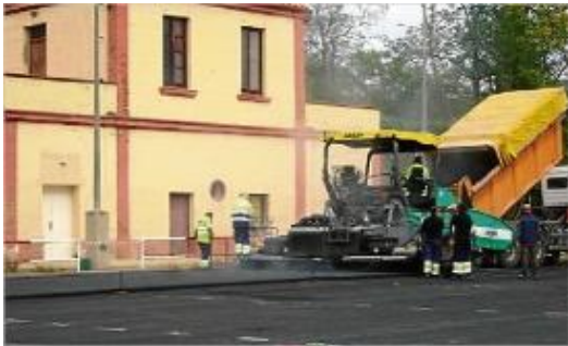
Els treballs d'adequació de la pista que s'utilitzarà per a l'esport.
