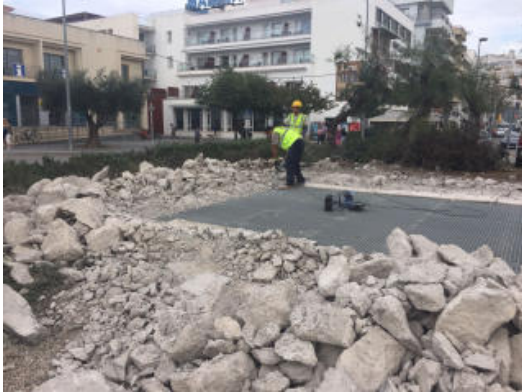
Les obres que es fan a la rotonda.
