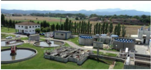
Imatge actual de la depuradora de Banyoles
