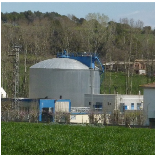
Les instal·lacions de tractament de les aigües residuals del riu Terri, situades al terme de Cornellà. Foto: R. E.
