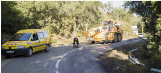
La carretera amb els operaris normalitzant la situació
