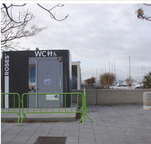
El mòdul instal·lat al port de Roses que està a punt d'entrar en funcionament Foto: AJUNTAMENT DE ROSES.
