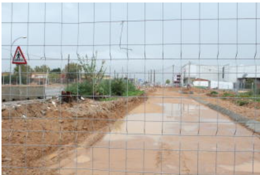
Les obres de desdoblament de la C-260 a Vilatenim.
