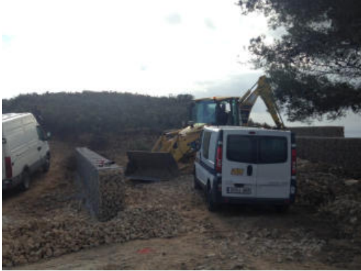
Les obres del mirador
