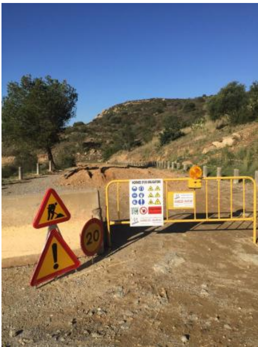
Un dels trams del camí que ja està en obres.
