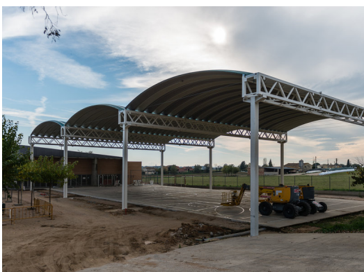
Una imatge de les obres de cobriment de la pista de l'escola Riudellots Foto: M. SUREDA.
