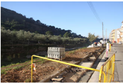
Les obres ja s'han iniciat.
