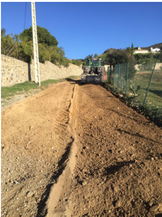
Les obres al camí ja s'estan executant.
