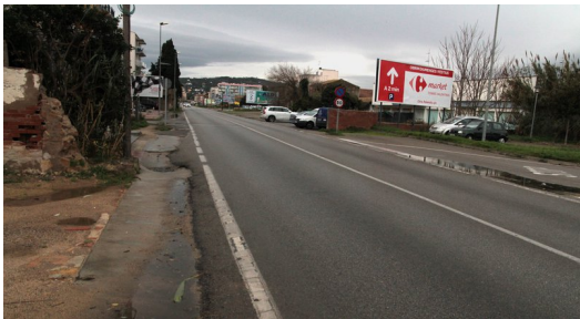
El tram de l'avinguda Catalunya de Sant Antoni que preveuen arranjat el 2017 Foto: E.A.
