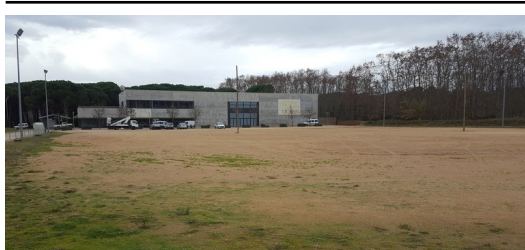
S'asfaltarà l'aparcament, ara de terra, de davant l'Espai La Pineda Foto: AJUNTAMENT DE ST. GREGORI.
