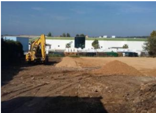
Les màquines han treballat per condicionar el terreny.
