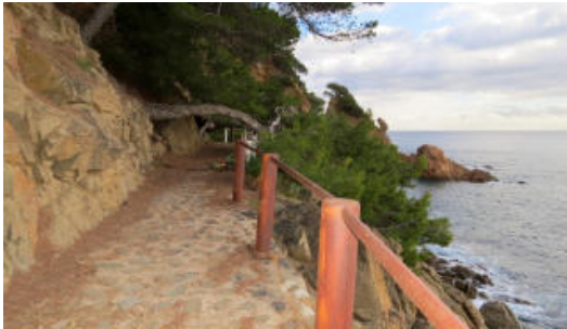
Obres al camí de ronda de Cala Bona
