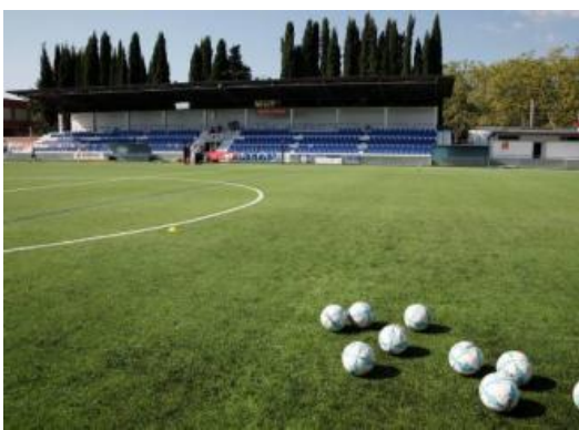
El camp de futbol d'on s'estan renovant les instal·lacions.
