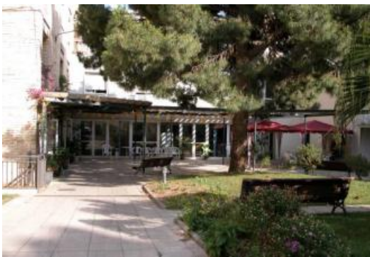
L'hospital sociosanitari de Lloret de Mar.
