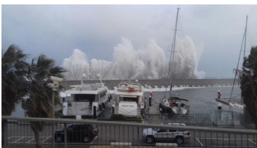
Espectacular imatge d'ahir de les ones xocant contra les instal·lacions del Port del Fòrum de Barcelona Foto: Jordi Estap
