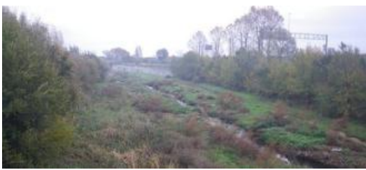
El tram del riu que s'ha netejat de vegetació
