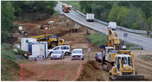
Els treballs al tram Medinyà-Orriols, en una foto d'arxiu
