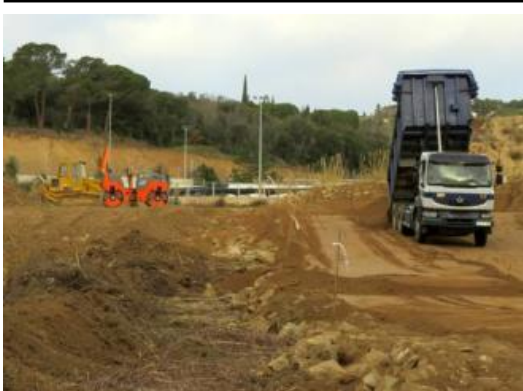
Les màquines han començat a realitzar moviments de terres.
