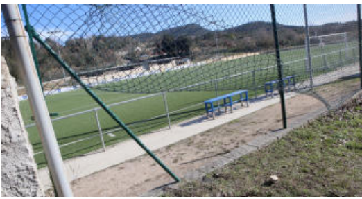
La reixa del camp de futbol va quedar en aquest estat
