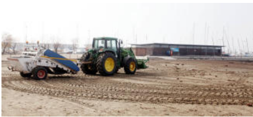
Les màquines treballant al tram proper al port
