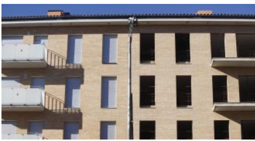
Pisos en construcció a la ciutat de Girona
