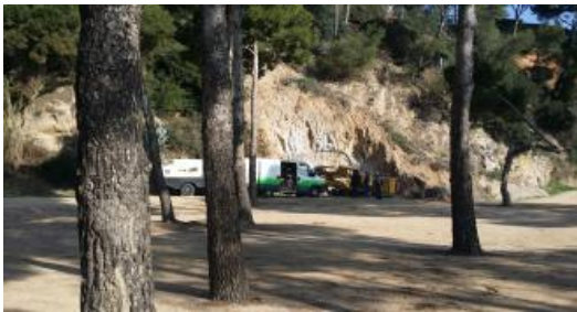
Imatge d'aquest dilluns de la màquina que perfora el talús per obrir l'accés
