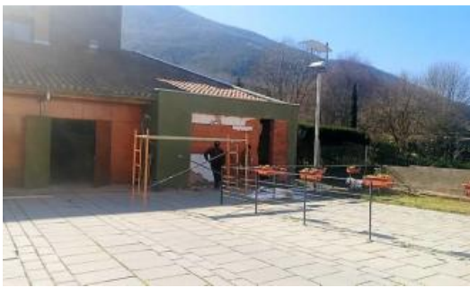
Les obres de la residència geriàtrica han començat.
