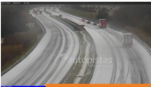
L'autopista AP-7 completament emblanquinada.
