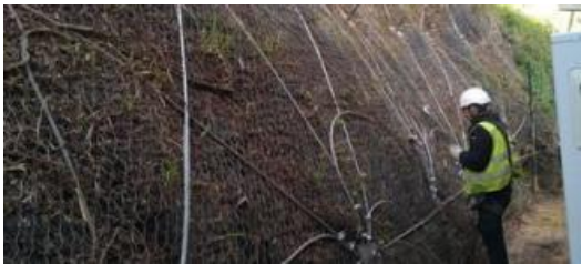
Les obres ja han finalitzat.
