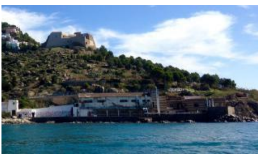
Antiga depuradora de marisc
