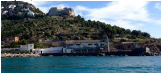
Les instal·lacions de l'antiga depuradora
