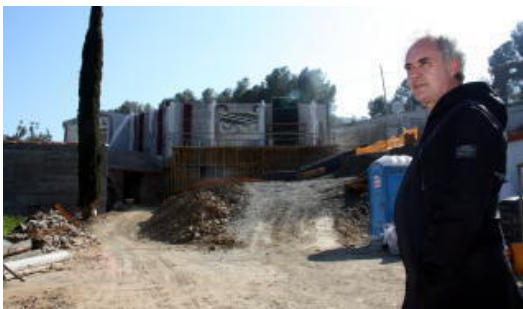
Obres d'ampliació del nou Bulli
