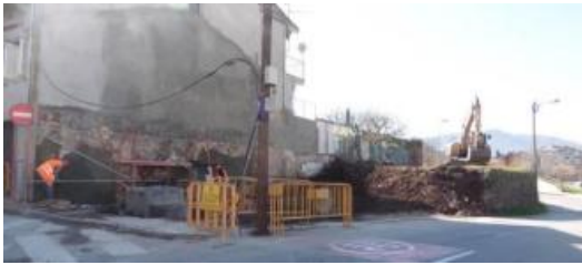
Enderroc al carrer Sant Cristòfor d'Olot
