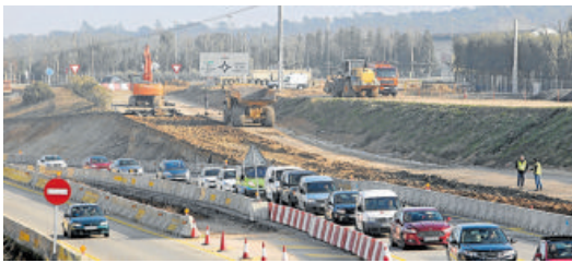
Maçanet-Sils: Els 4,7 km d'obra més llargs de la història
