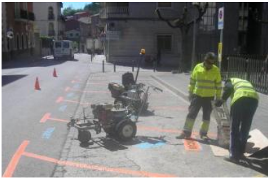
Operaris treballant en el canvi de la zona d'aparcament controlat de Ripoll.
