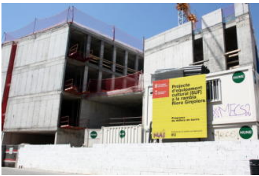
L'edifici que s'està construint
