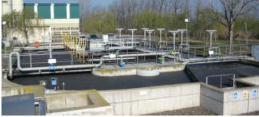
Vista actual de la depuradora.
