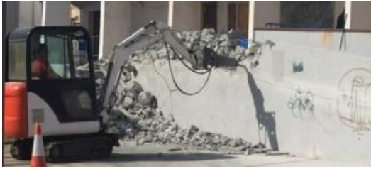
Enderroc d'una part de la barana de la plaça de Pere el Gran.
