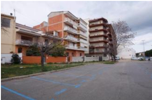
El carrer de les Gavines, amb els edificis que són de Platja d'Aro.
