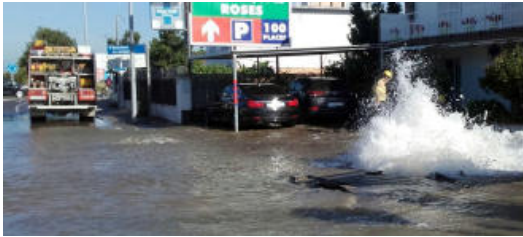
Una fuga d'aigua provoca un col·lapse de trànsit a Roses
