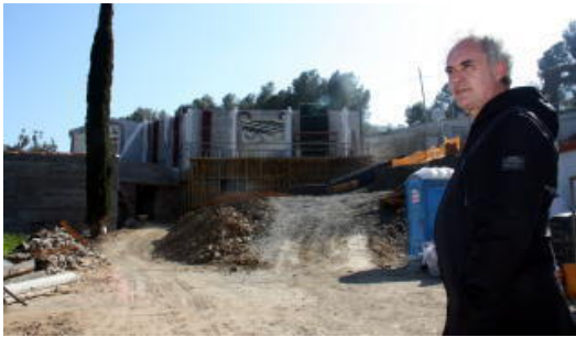
Obres d'ampliació del nou Bulli
