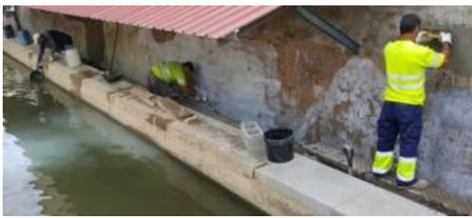
Imatge dels treballs al safareig públic.
