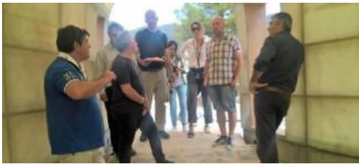
El cuiner, en una visita a les obres, que van avançant.
