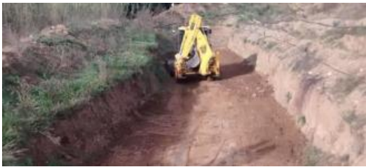
Execució d'un tram del circuit, ara ja sense activitat.
