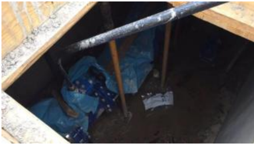
Les obres d'instal·lació de l'arqueta ja han finalitzat.
